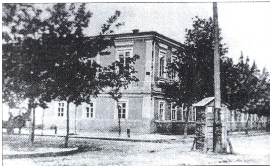
Рис. 18 Здание реального училища, размещавшегося в доме Федюхина
