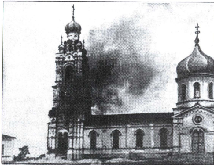
Рис. 12 Пантелеймоновская церковь. Горят деревянные опоры выбитой стены
