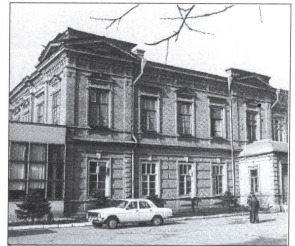
Рис. 17 Административное здание Станкозавода, в котором размещалась Казанская домовая церковь
